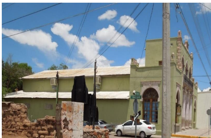
Fachada lateral izquierda
