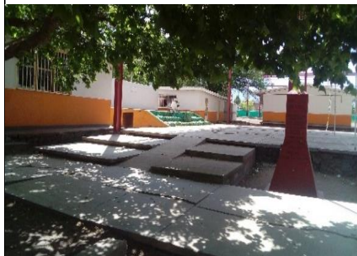
Vista desde la entrada principal
