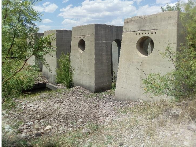
Pilares del aserradero (Peña, 2017)
