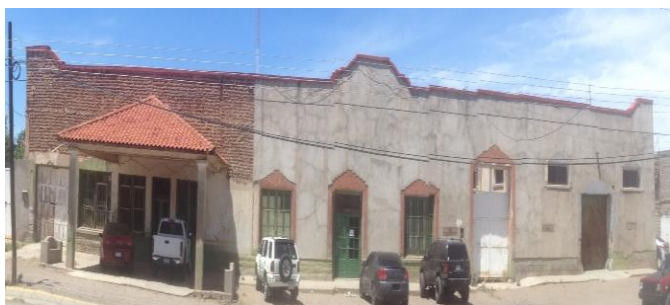
Vista del edificio
