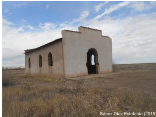
Estructura de la iglesia
