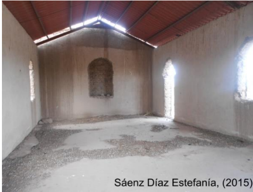
Interior de la iglesia
