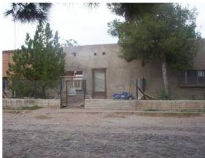
Fachada principal del lado izquierdo
