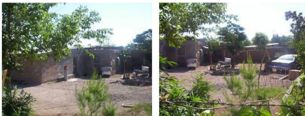
Fachada principal, Av. Libertad
