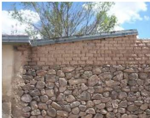
Muro antiguo de adobe y piedra
