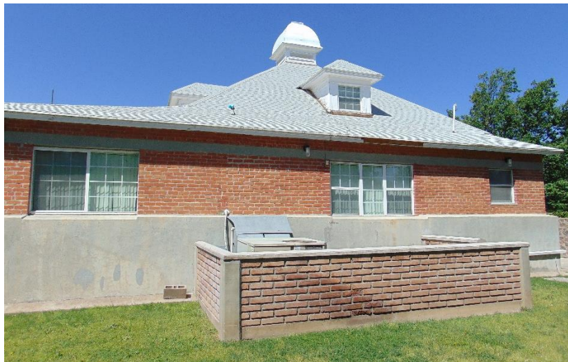
Parte trasera del edificio (Holguín, 2017)
