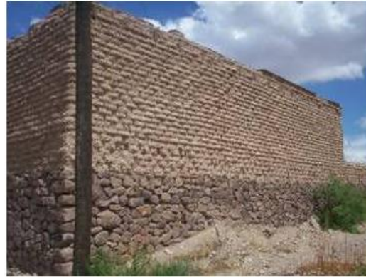
Parte de atrás del predio, esquina Victoria y Allende.
