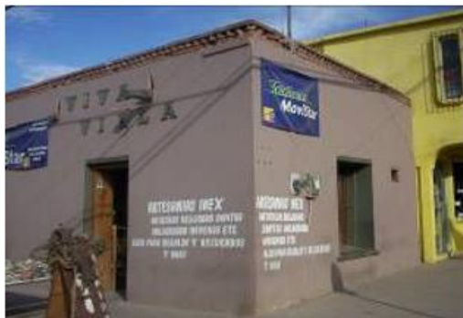
Fachada principal y lateral
