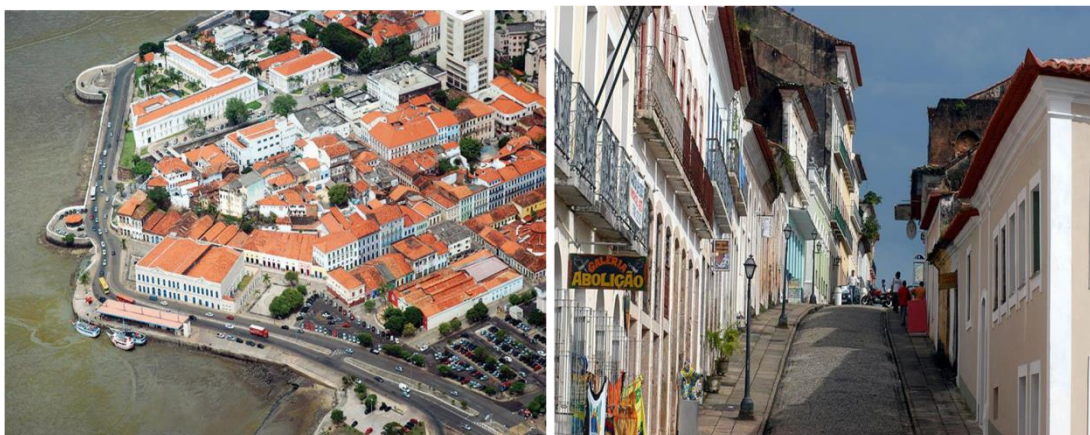
Figura 1- Vista aérea do centro histórico e dos casarões da Rua do Giz.
