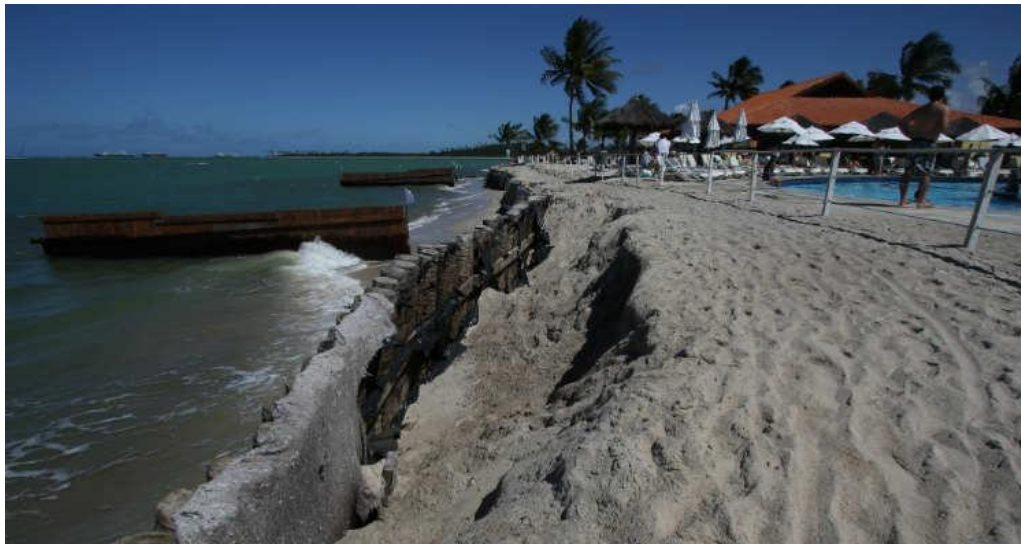
Figura 1 - Obra para aumento da faixa de praia Fonte: Azevedo (2018)
