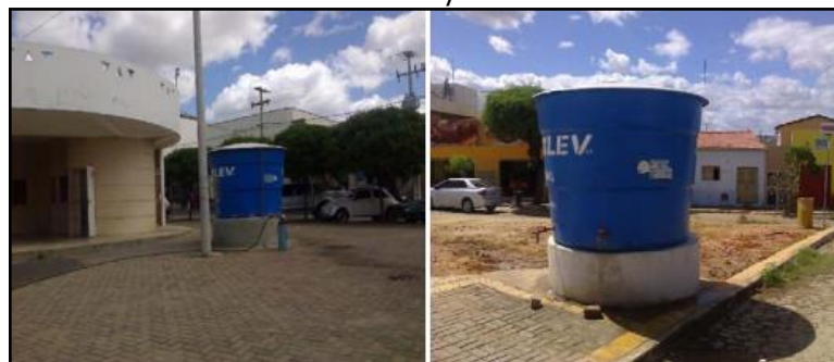
Figura 6 – Caixas d'água de Polímero na Praça da Matriz e Praça São Benedito – Pau dos Ferros/RN
